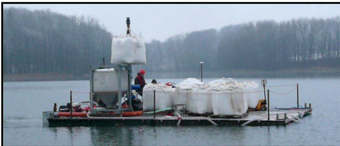
Εικόνα: Εφαρμογή του κροκιδωτικού σε λίμνη
