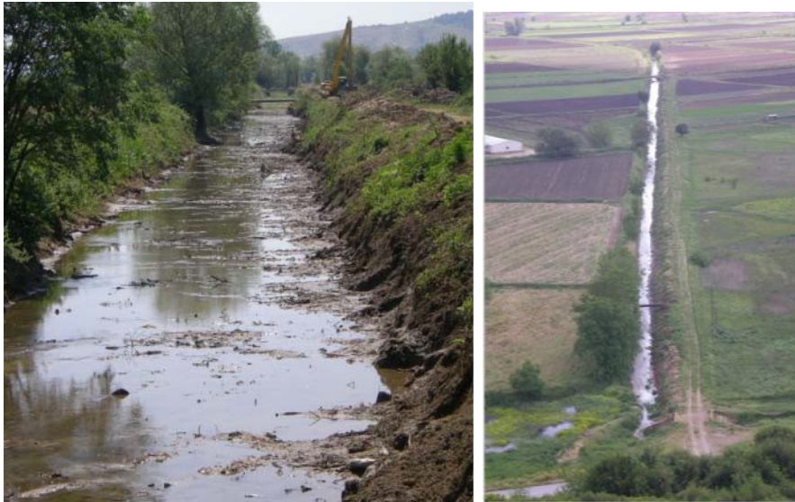
Φωτο4. Αποψη της Τάφρου Λαψίστας
